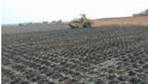
Gambar 7. Melakukan Pekerjaan Compaction (Pemadatan Tanah) dengan Alat Sheep Foot Roller
