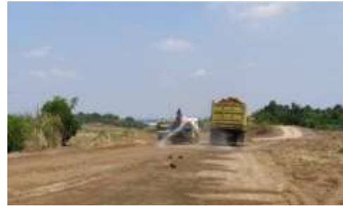
Gambar 8. Melakukan Tahapan Pekerjaan Penyiraman Tanah
