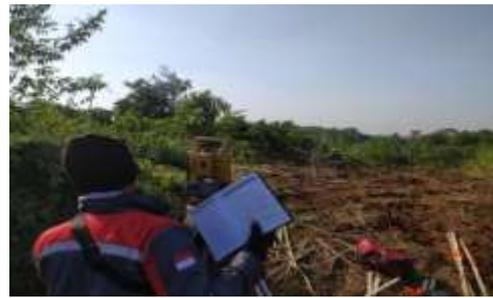
Gambar 5. Melakukan Pekerjaan Pengukuran Eksisting Dengan Menggunakan Alat Total Station Pada Area Memorial Park
