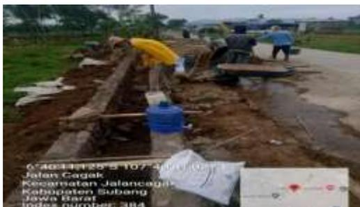
Gambar 4. Pengecekan Tinggi Pemasangan Batu
